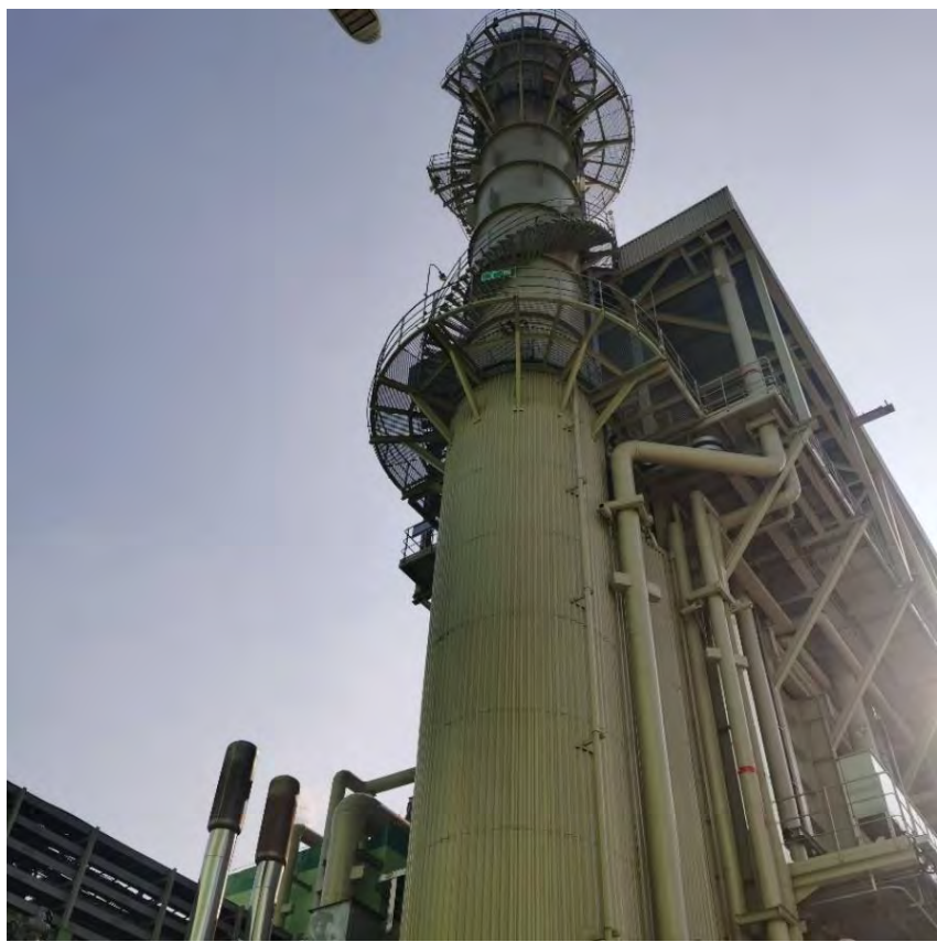
DA010 排气筒及采用平台照片
