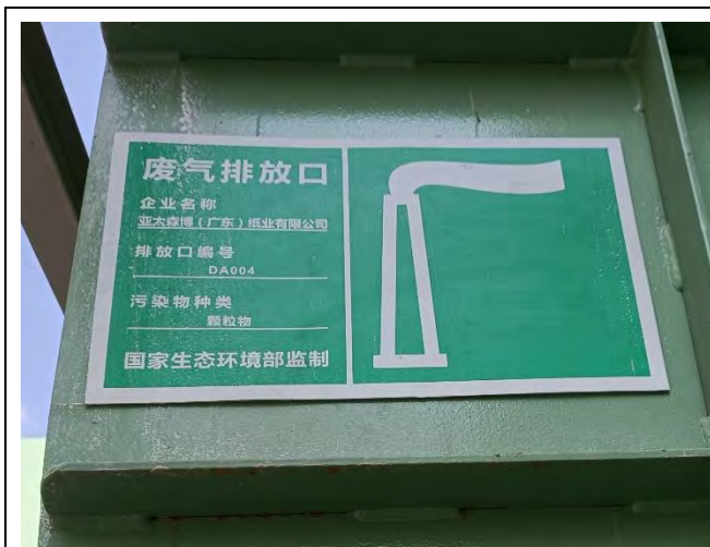
废气标志牌 DA004 (现有)
