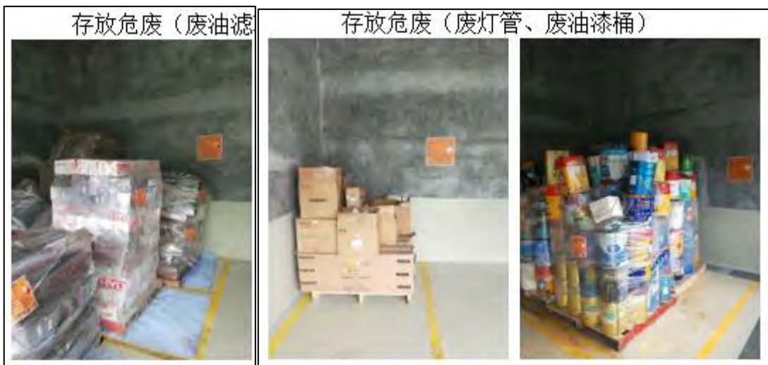
图 9.4-7 危废暂存间内部分区标签
