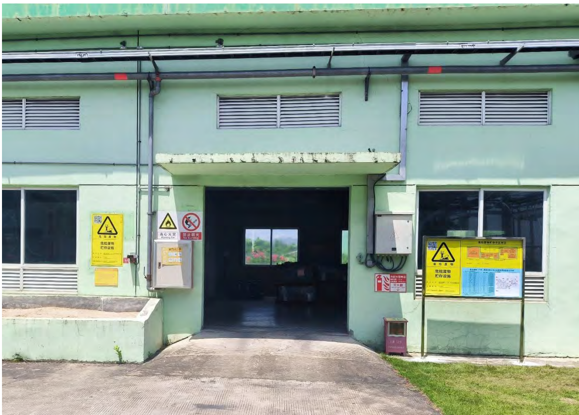
图 9.4-4 危废暂存间外部标志牌
