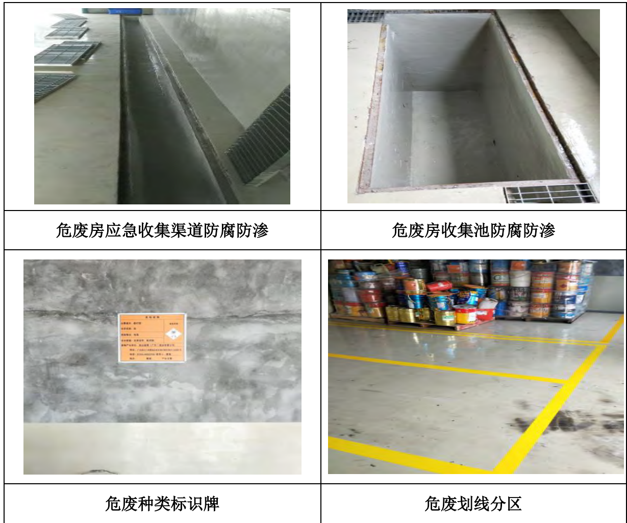
图 4.1-3 各依托工程的环保治理设施照片
